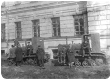
Во дворе Главного корпуса ТИИ, подготовка к посевной
