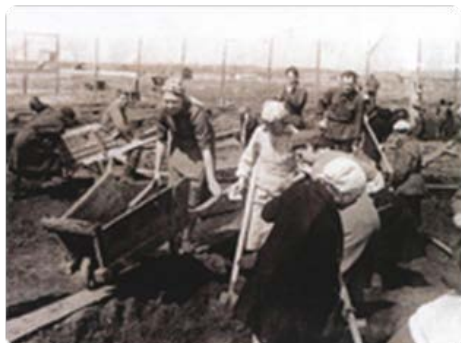
В Томске катастрофически не хватало электроэнергии. Чтобы избавиться от этого дефицита, было принято решение о строительстве новой электростанции - ГРЭС-2. Студенты ТПИ (ТПУ) на строительстве
