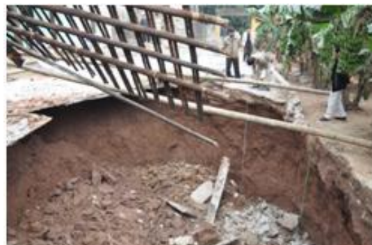
Рис.2 Суффозионная воронка площадью 30 м 2 [1]
