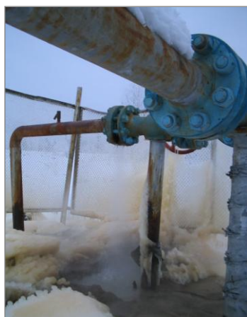
Рис. 3. Разгерметизация ВВД по фланцевому соединению узла врезки, Каргасокский район, декабрь 2005 г. (фото автора)
