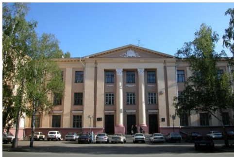
8 корпус ТПУ – второй горный
