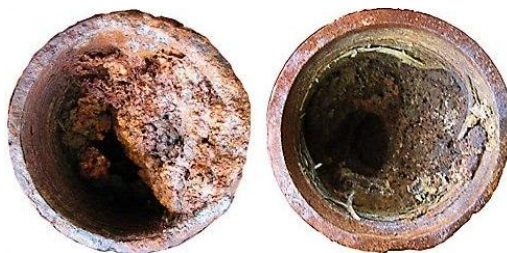
Abb. Ausfällung der Asphaltharzparaffinablagerungen in den Pumpenkompressoröhrren
