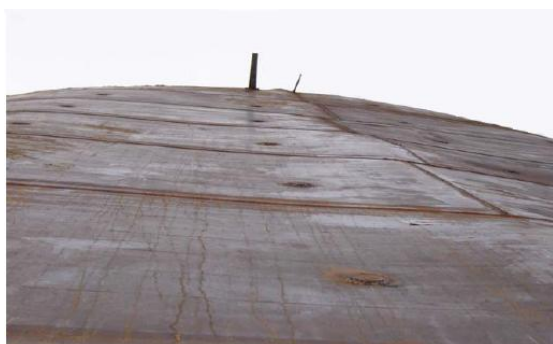
Рис. 1. Несовершенства геометрической формы в зоне монтажного стыка РВС 10 000 м 3
