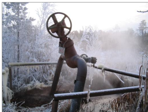
Рис. 1. Разгерметизация ВВД по фланцевому соединению узла задвижек, Каргасокский район, декабрь 2005 г. (фото автора)
