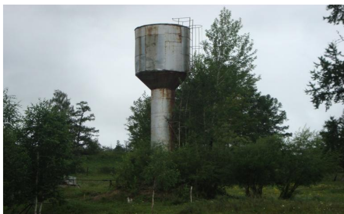
Рис.2 Водоснабженческая скважина «Молодёжная» с водонапорной башней
