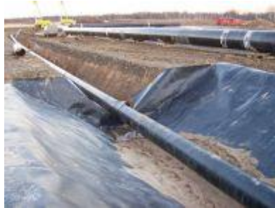
Рис. 2. Водонепроницаемые траншеи в насыпи
