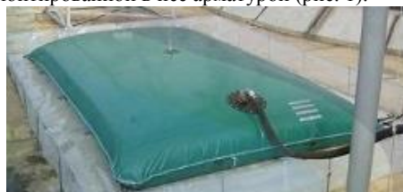
Рис. 1. Внешний вид полимерного эластичного резервуара
