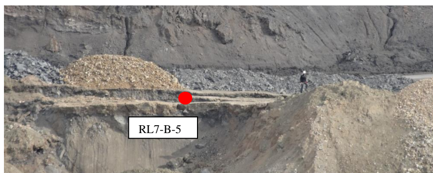
Рис.2 Деформации в районе профильной линии RL7-B (5-ый рабочий репер)
