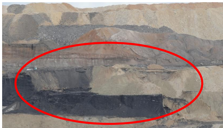
Рис.1 Район деформаций карьерных откосов (гор +450м.- +425м)
