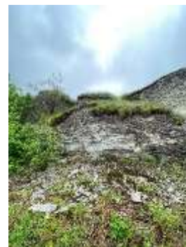
Рис. 4. Вид на тело старого оползня на левом берегу р. Великой
