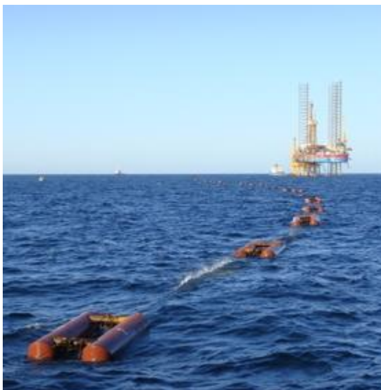
Рис. 1 Tow-in перемещают по дну
