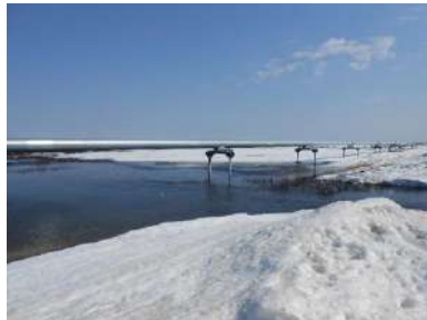
Рис. 4. Подтопление, в результате нарушения естественного стока.
