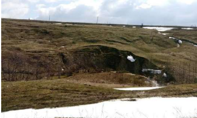
Рис. 1. Оползневой склон км 615
