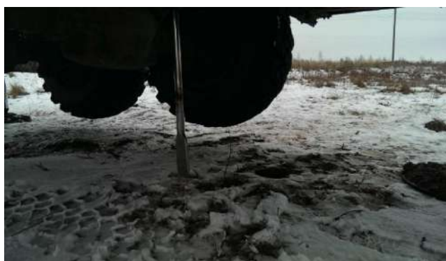
Рис.2 Испытания грунтов dilatометром РД-100
