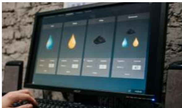
Рис. 3. Открытое окно SCADA-системы на рабочем месте оператора
